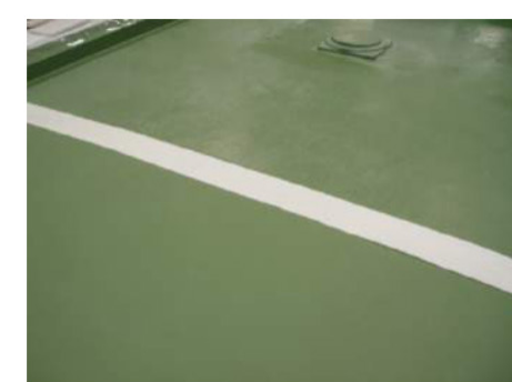
Figura 4. La superficie debe quedar limpia y homogénea.
