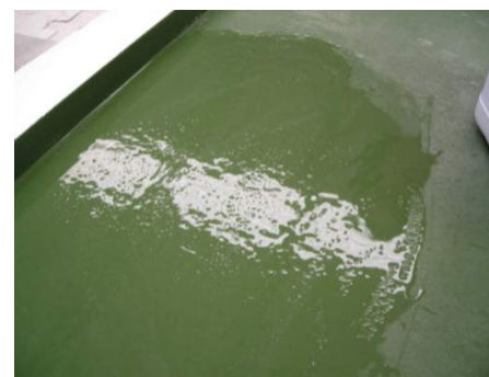
Figura 3. Tras frotar el producto, la zona de aplicación debe quedar como en la imagen.
